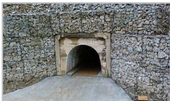
З. Совмещенный оголовок при ремонте трубы
