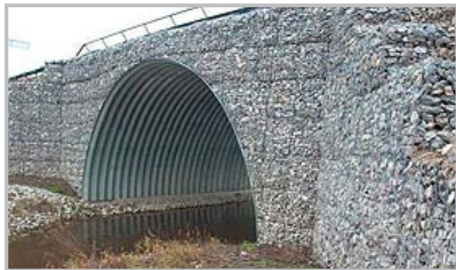
Г. Портал из габионов с откосными крыльями
