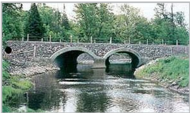
В. Железобетонный воротниковый оголовок
