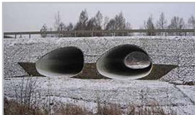
Б. Срез по форме откоса оголовком из габионов
