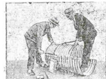
Фиг. 39. Загибание скрепы при затянутой стяжной цепи.
