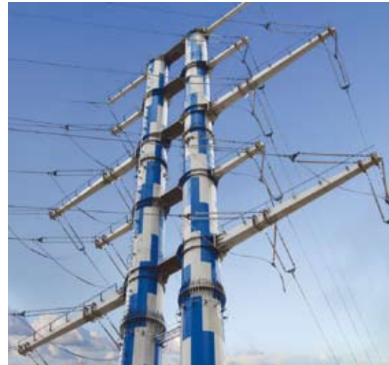
Четырехцепная двухстоечная анкерно-угловая опора ВЛ 220 кВ в Новой Москве
